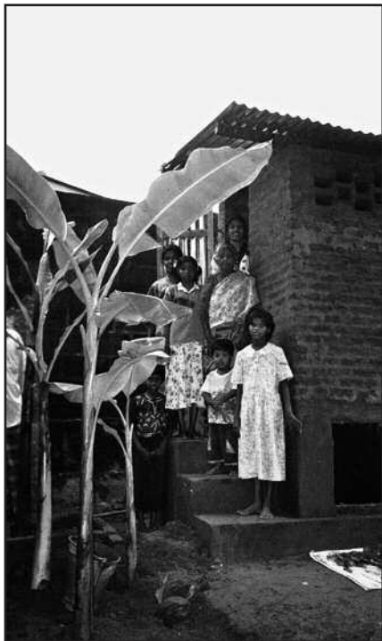
Nouvelles toilettes sèches au Kerala
